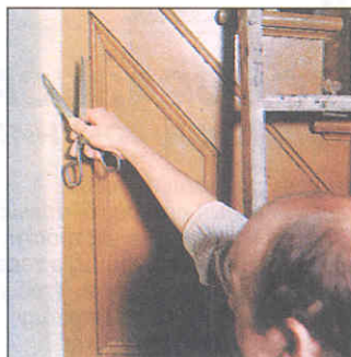
В месте примыкания обоев к дверной филанке или обшивке из досок их выступающую часть помечают ножницами или отверткой.
