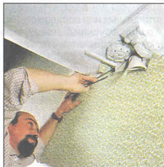
У примыкающей к стене лепнины потолка обои прикладывают к основе, помечают «препятствие», снова их отрывают от потолка и в нужном месте разрезают.
