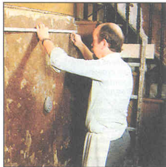
Тщательная разметка — залог успешной работы. Первым приклеивают наиболее длинное полотнище обоев, предварительно разметив положение его кромки на стене.
