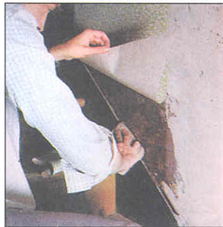
У тетивы лестницы обои приклеивают так же, как и у плинтуса: сначала на них делают соответствующую метку, затем их в этом месте обрезают.
