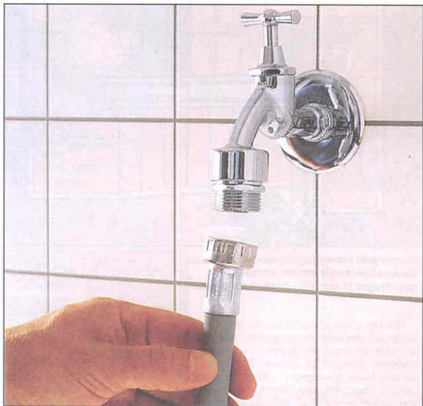
Вентиль для подключения автоматических стиральных и посудомоечных машин имеет клапан, предотвращающий возврат воды в водопровод и вантуз.
